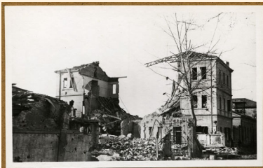
Danni causati dai bombardamenti ad edifici in Viale XXIII Marzo ( fototeca dei Civici Musei di Udine )
