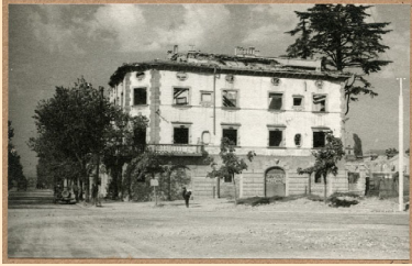
Danni causati dai bombardamenti ad un edificio in Viale della Stazione ( fototeca dei Civici Musei di Udine )
