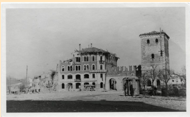
Danni causati dai bombardamenti agli edifici in Piazzale D'Annunzio (fototeca dei Civici Musei di Udine)
